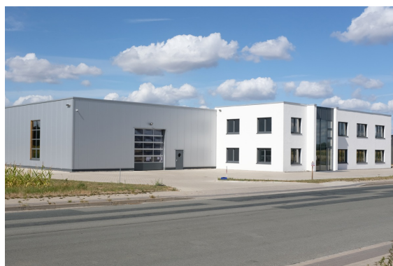
Neubau Halle und Büro
