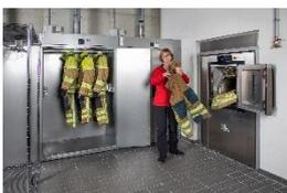
Bildunterschrift: Trennwand-Waschmaschinen von Electrolux Professional verhindern eine Kreuzkontamination zwischen den verunreinigten und den aufbereiteten Textilien einer Feuerwehr, die Trockenschränke ermöglichen ein schonendes Trocknen und die Reaktivierung der Imprägnierung von Feuerweherschutanzügen.
